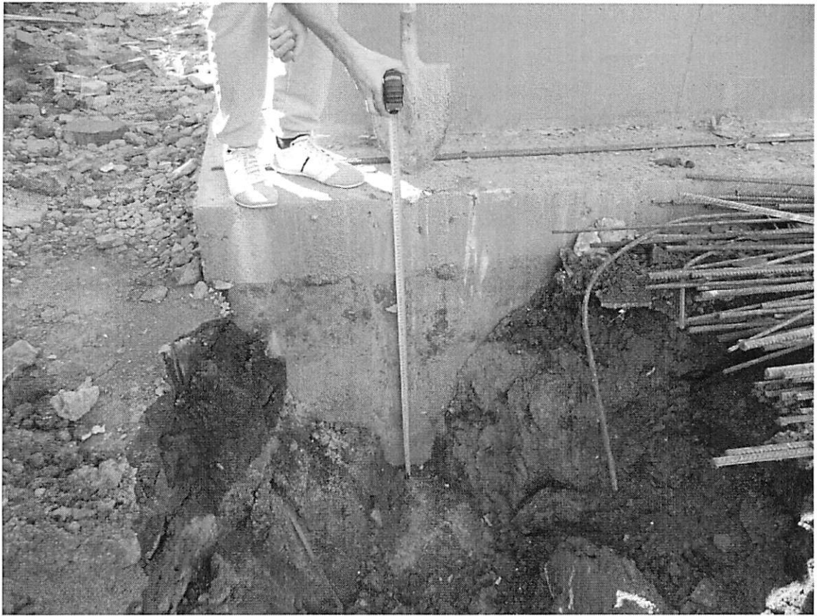
Фото 3. Шурф под фундаментную плиту.
