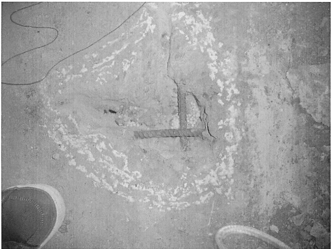
Фото 20. Армирование плиты перекрытия.
