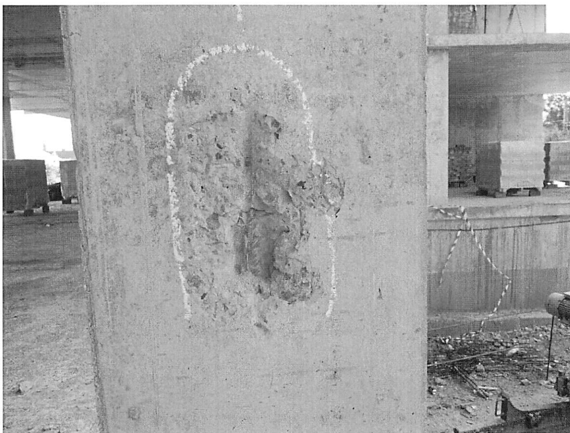
Фото 21. Армирование колонны каркаса.
