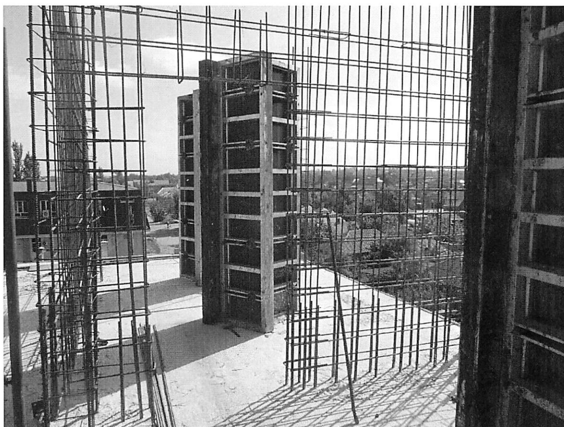
Фото 24. Армирование диафрагмы жесткости и колонны.
