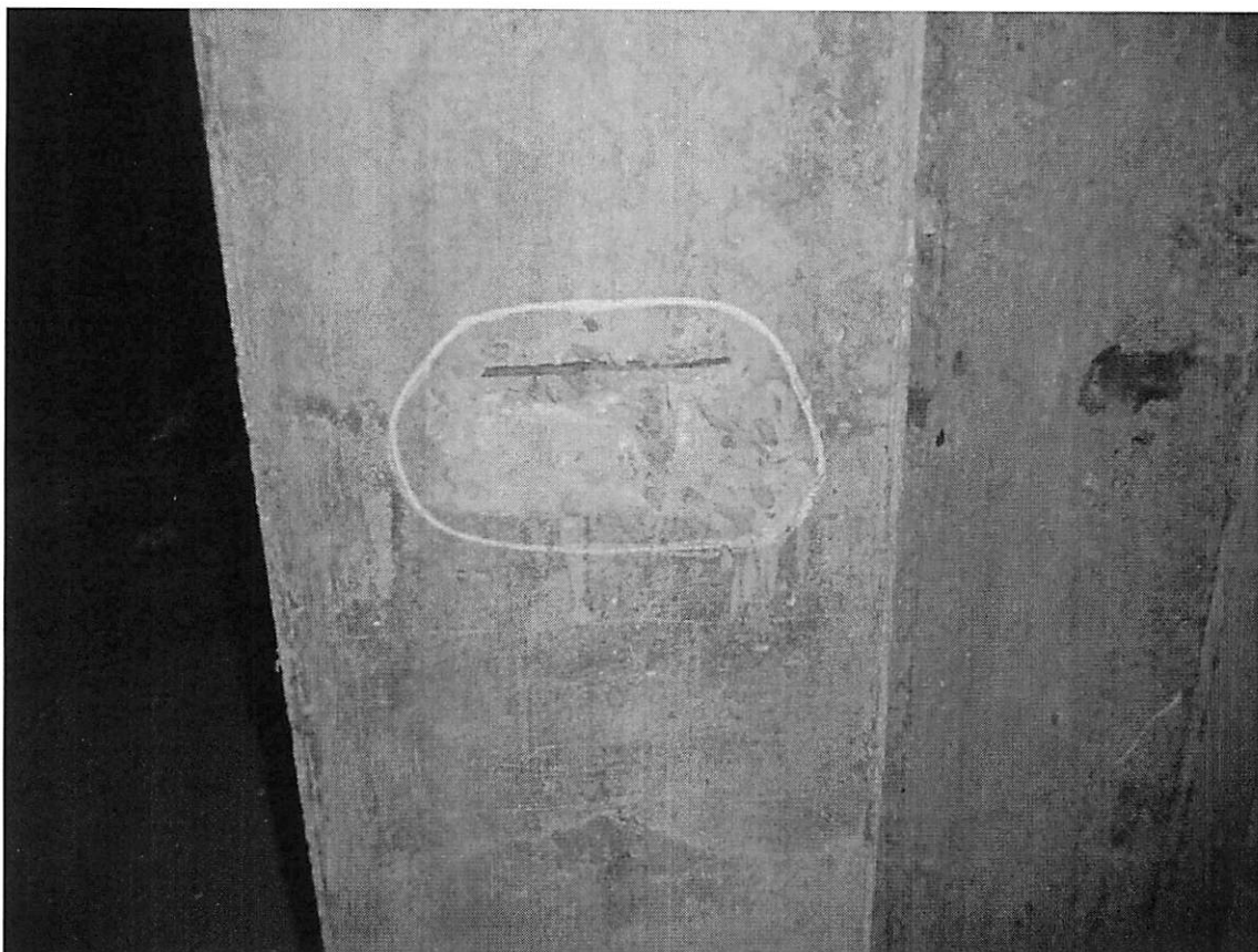
Фото 17. Армирование колонны каркаса.
