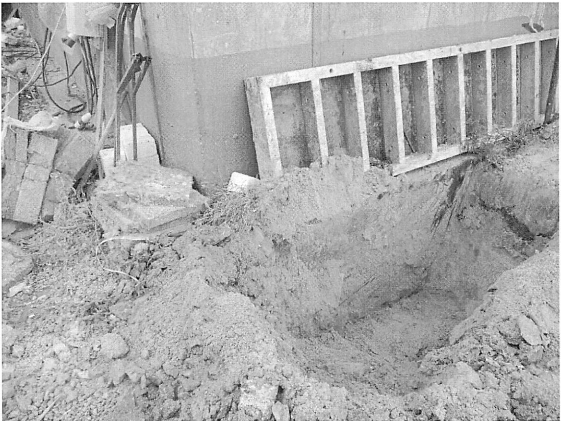
Фото 4. Шурф под фундаментную плиту.
