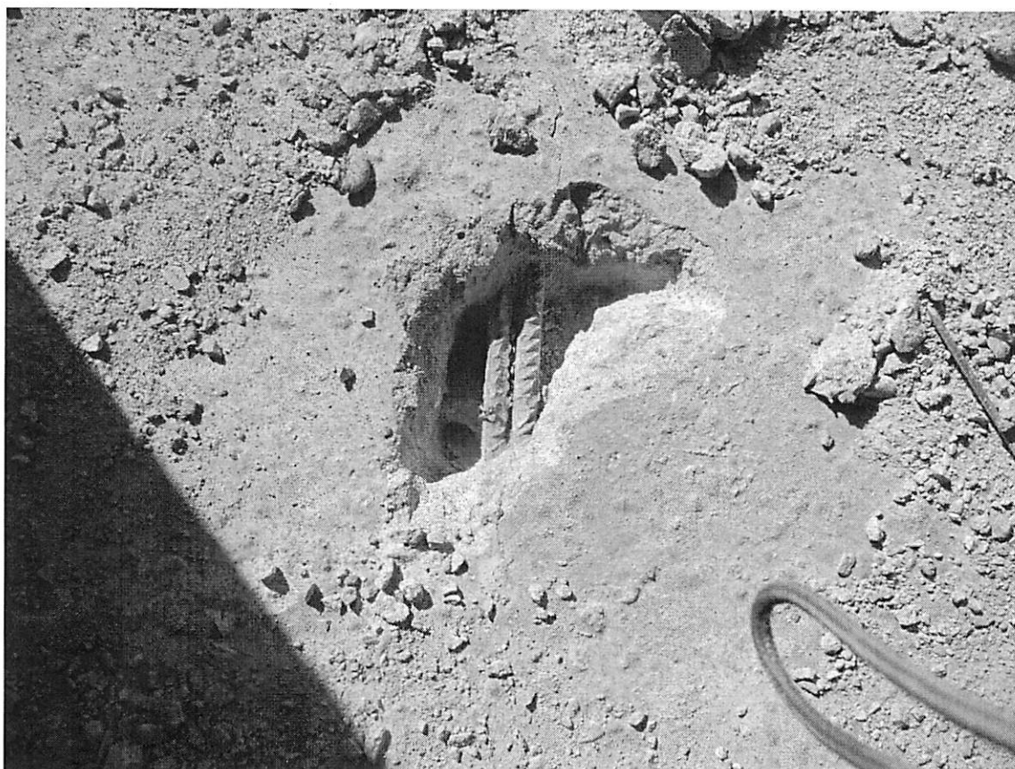
Фото 23. Армирование плиты перекрытия.
