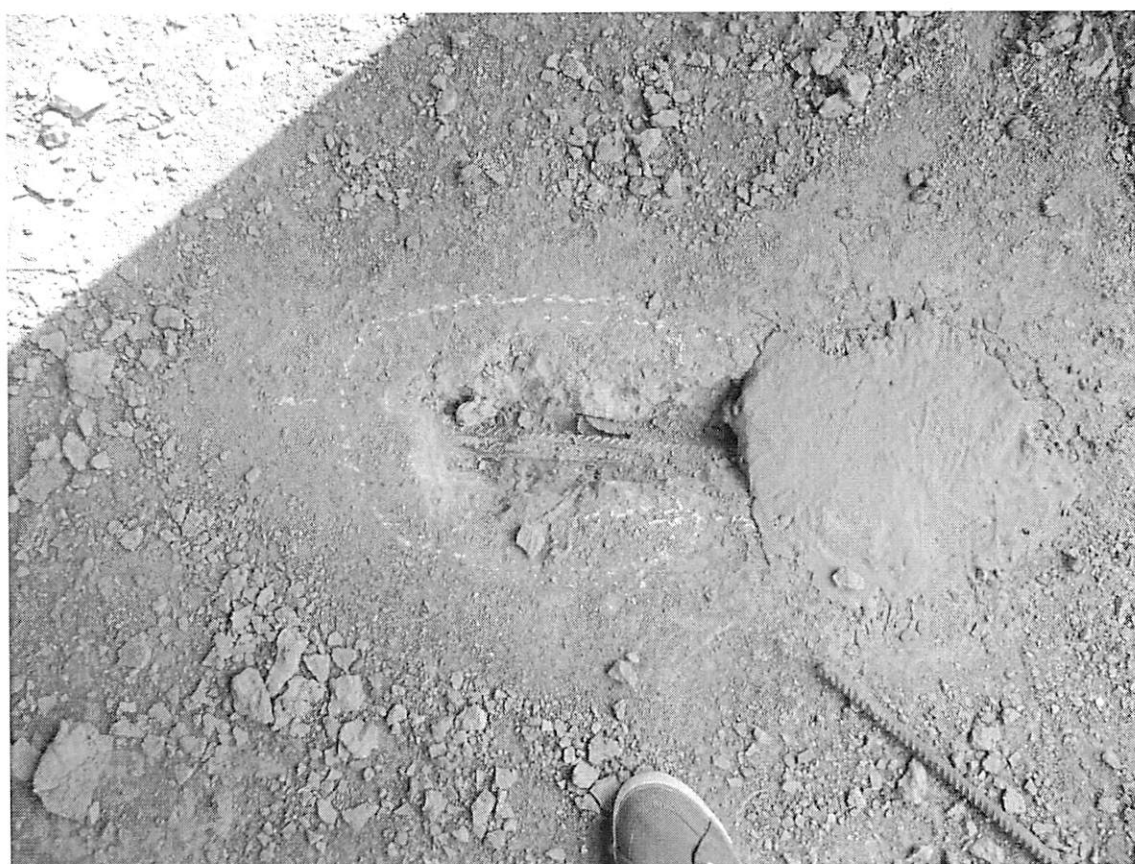
Фото 22. Армирование плиты перекрытия.
